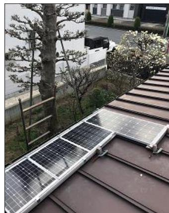
屋根に傷をつけないように、クランプというねじ止めにして、穴をあけずに取り付けられています。こうすることで3割くらい発電量がアップしました。
